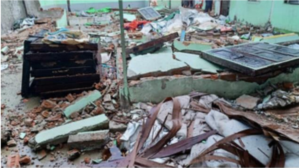
倒壊した建物
